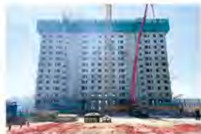
顺义临河棚改工程主体结构全面封顶
