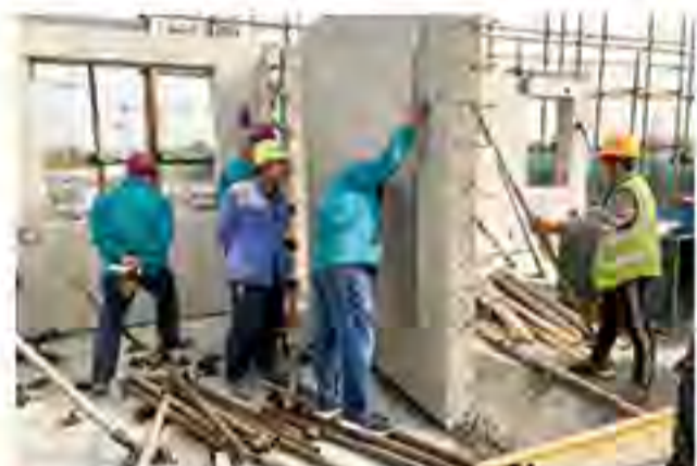
南苑A区棚改五标18号楼 预制构件首段吊装完成
